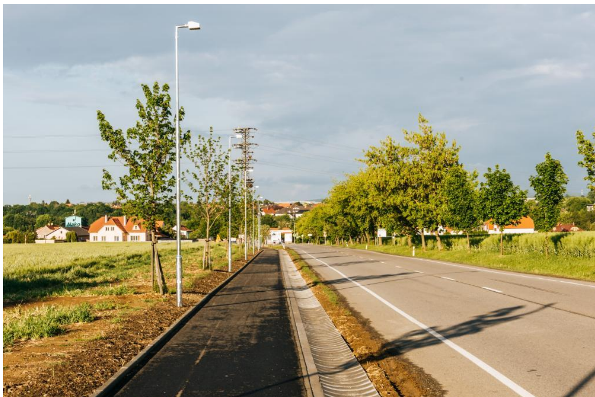
Obr.1 Foto soustavy VO a přilehlého dopravního prostoru autor [1].
